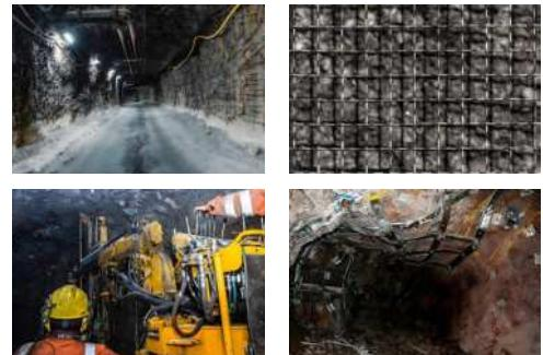
矿用钢筋网是专为矿山行业设计的高强度、耐磨的金属网产品。采用优质的防腐、耐久材料，通过电焊工艺精制而成。其结构坚固，网孔整齐，为矿山巷道支护和设备防护提供卓越的支持和保护。
