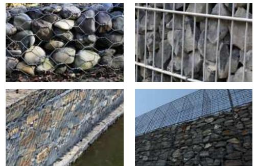
石笼网是一种由镀锌或 PVC 镀锌钢丝编织而成的网状结构，通常被用于土石工程、河道防护、环境治理等领域。它的结构简单，安装方便，能够有效地防止土石坍塌、护岸、护坡，具有良好的透水性能，被广泛应用于各种土木工程。
