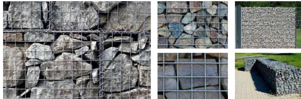
电焊石笼网是一种由焊接而成的石笼结构，采用电焊技术将金属线焊接成网格，填充石块或其他填料形成坚固的结构。它具有良好的抗冲击性、稳定性和透水性，广泛用于防护、河道整治、环境美化等工程。
