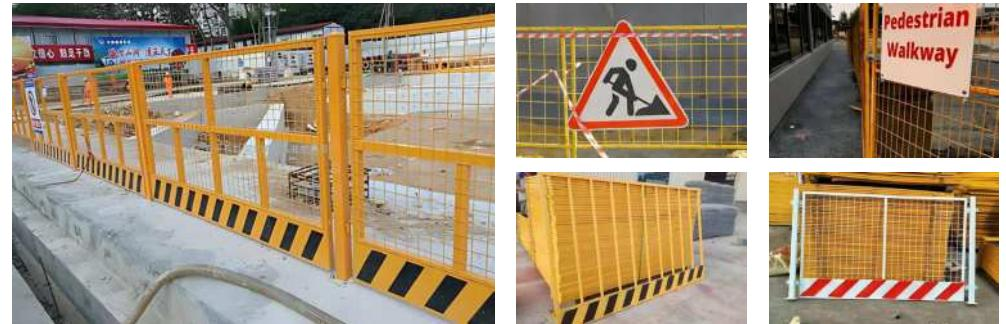
工程施工护栏网是一种专为建筑、道路施工等工程现场围挡和防护设计的金属网产品。采用高强度、耐久的材料制成，结构坚固，安装灵活，为施工现场提供有效的隔离和安全保护。
