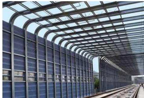
轨道交通声屏障是一种专为降低交通噪音而设计的结构，旨在有效隔离轨道交通产生的噪音，确保周边居民和环境的安宁。具有卓越的隔音效果，能够有效减少轨道交通噪音对周围社区和环境的干扰。
