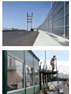
桥梁声屏障是专为降低桥梁交通噪音而设计的结构，旨在有效阻挡车辆产生的噪音，保护周边居民和环境的安宁。具有卓越的隔音效果，可有效降低桥梁交通噪音对周围社区和环境的影响。
