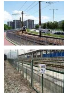
铁路护栏是一种用于保护铁路线路安全的重要设施。采用高质量的热浸镀锌钢材制成，具有卓越的防腐性能和耐久性。该护栏设计合理，结构牢固，能够有效隔离铁路线路，确保列车运行的安全和畅通。
