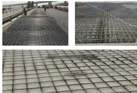
桥面钢筋网是一种专为桥梁工程设计的高强度金属网产品，采用优质钢材，通过精湛的焊接工艺制成。其设计合理，结构坚固，主要用于加强和支持桥梁结构，提高桥面的承载能力和耐久性。
