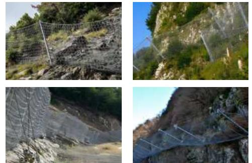
边坡防护网是一种用于防止边坡滑坡、土石流等自然灾害的防护结构。它采用耐候性和耐腐蚀性优良的材料制成，能够有效固定土石，防止土壤侵蚀，保护边坡的稳定性。边坡防护网广泛应用于道路、铁路、水利、矿山等工程中，发挥了重要的防护作用。
