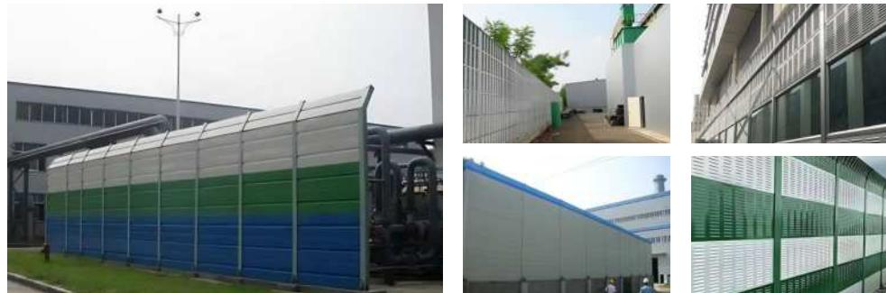
厂区声屏障是专为工业厂区设计的声学屏障，旨在有效降低厂区内机械设备、生产作业等产生的噪音，为周边环境提供安静的工作和居住环境。采用高品质材料制成，具有良好的隔音效果和耐用性。
