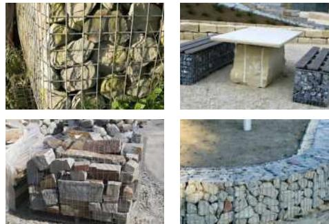
石笼网箱是一种由镀锌或 PVC 镀锌钢丝编织而成的箱状结构，通常用于土石工程、河道防护、环境治理等领域。它采用开放式设计，具有良好的透水性能，可以有效地防止土石坍塌、护岸、护坡，并在水利、交通、环保等工程中发挥重要作用。
