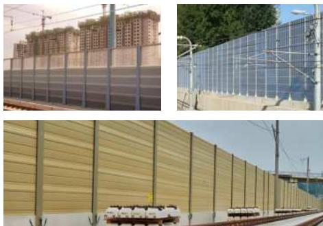
铁路声屏障是一种专为降低铁路运输噪音而设计的声学隔音设施，旨在有效隔离火车行驶过程中产生的噪声，减缓对周围居民和环境的影响。具有卓越的隔音效果，铁路声屏障有助于改善铁路周边区域的生活质量。
